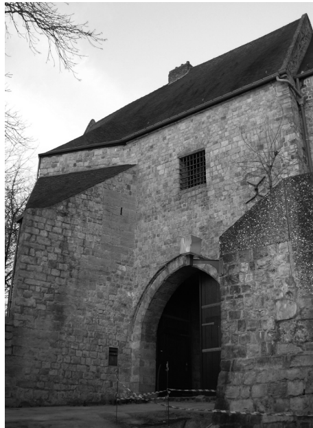
Het poortgebouw van de burcht te Mons (foto : F. Doperé).
